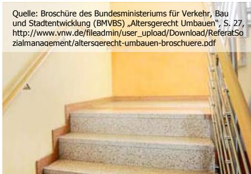
**Abbildung 59: Ein zusätzlicher Handlauf bringt mehr Sicherheit im Treppenhaus**
